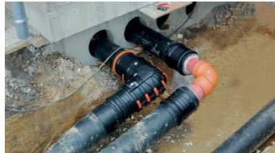
14. Clip-Flex-Muffen mit d160/250-mm-Rohrverbindung
